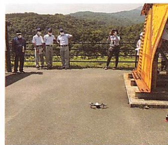
ドローンによる祭時大橋調査
