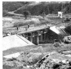
進む鉄橋の復旧
