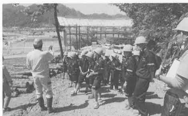
フィールドワークの様子（建設中の鶴住居復興スタジアム）
